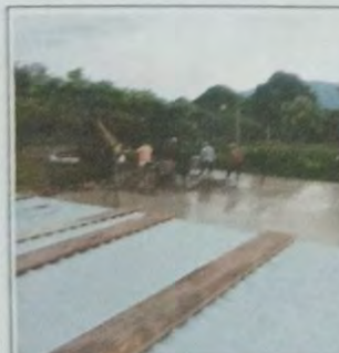
Foto 17: MODULO A Vista de proceso de fundición de losa, con cuadrilla de personas. Vista de superficie ya aplicada en concreto con acabado final.
