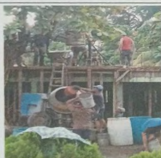
Foto 15: MODULO A Se puede apreciar ya la armadura conformada con hierro No 3 y No 4 para colocación de esperas para futuras gradas. Vista del proceso de fundición donde se está utilizando la concretara para realizar el terciado adecuado.
