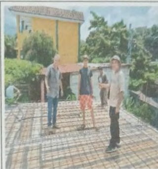
Foto 14: MODULO A Vista de AULA se está trabajando en el armado de la losa, se revisa el desarrollo de bastones, en general la conformación de la canasta estructural por paneles de apoyo. Está en proceso de fundición dando el espaciamiento de el concreto sobre la armadura.
