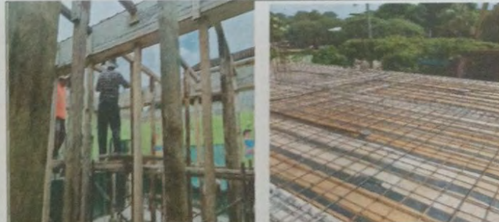
Foto 12: MODULO A Vista aerea donde se puede apreciar el area de terraza ya con arandura de refuerzo No 3 colocada, así mismo la ducteria de 3/4 pig para es sistema electrico.
