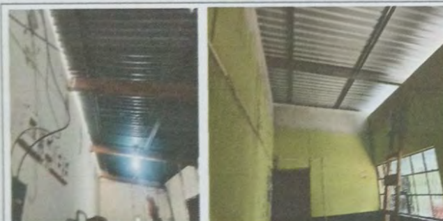
Foto 9: MODULO A Vista interna de direccion donde se cambio la estructura de metal y lamina de zinc por estructura nueva y lamina troquelada cal 26
