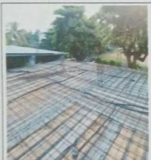
Foto 15: MODULO A Se puede apreciar ya la armadura conformada con hierro No 3 y No 4 para colocación de esperas para futuras gradas. Vista del proceso de fundición donde se está utilizando la concretara para realizar el terciado adecuado.
