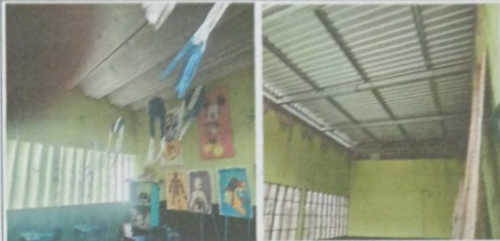
Foto 8: MODULO A Vista interna de AULA se cambio la cubierta de asbesto por cubierta a base de estructura de metal y lamina troquelada cal 26.
