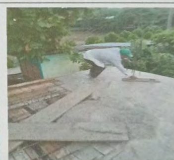
Foto 16: MODULO A Vista de colocación de refuerzo en el armado de losa y colocación de ductería para instalación eléctrica, con las cajas octogonales colocadas en puntos estratégicos para mejor distribución de iluminación. Vista de conformación de mezcla para darle el acabado final.
