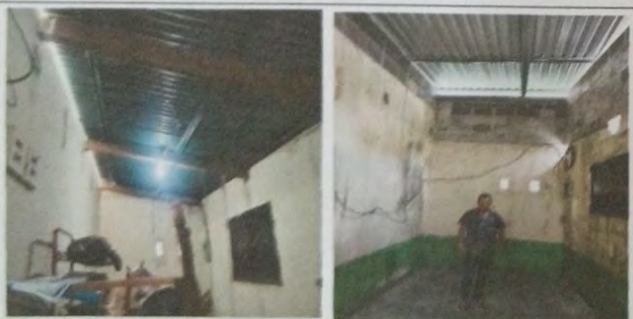
Foto 5: MODULO A Vista interior de area para bodega donde se cambio cubierta de lamina de zinc en mal estado por lamina troquelada cal 26,+ cambio estructua de metal.
