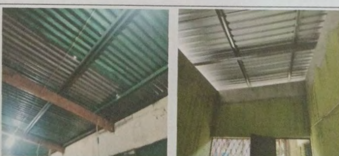
Foto 6: MODULO A Vista interior de espacio para direccion, donde se cambio cubierta de lamina de zinc en mal estado por lamina troquelada cal 26.+ cambio estructua de metal.
