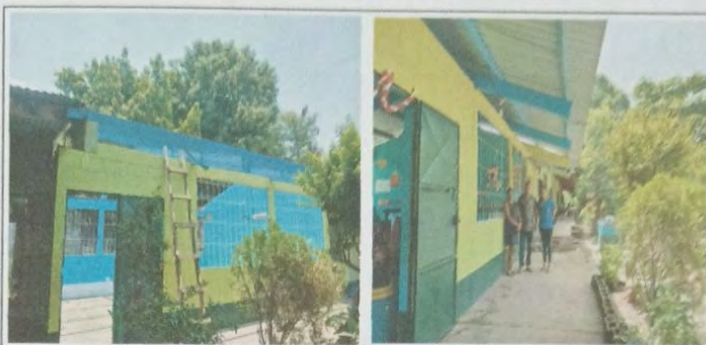
Foto 2: MODULO B Vista con integrantes de la junta escolar y Personal docente. Se cambio la cubierta existente de lamina de zinc por lamina troquelada cal 26.
