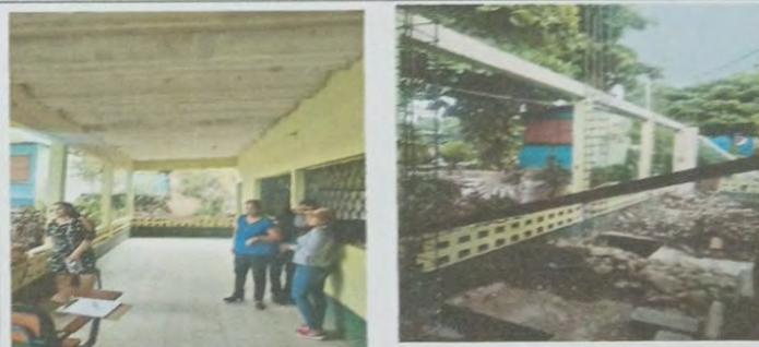
Foto 10: .Vista de AULA proceso de cambio de cubierta de asbesto por losa de concreto previo a esto se esta reforzando muros con columnas y zapatas.
