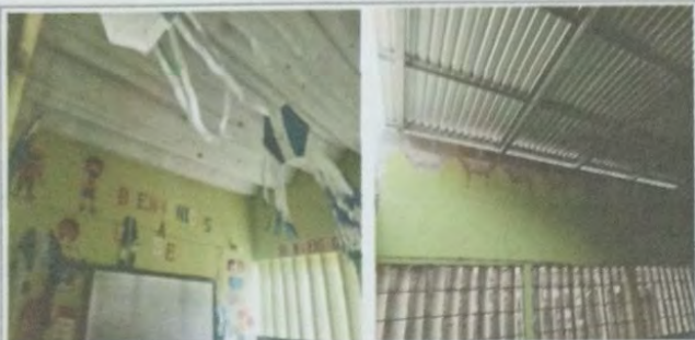
Foto 7: MODULO A Vista interior de aula donde se cambio la cubierta de asbesto por cubierta a base de estructura de metal y lamina troquelada cal 26.
