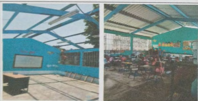
Foto 3: MODULO B Cambio de cubierta de lamina de zinc en malas condiciones por lamina troquelada cal 26.
