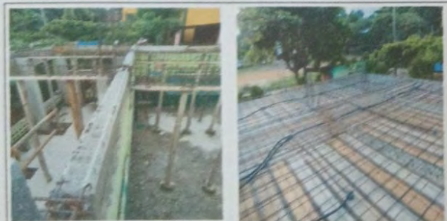
Foto 11: MODULO A Vista aerea donde se puede apreciar el area de terraza ya con arandura de refuerzo No 3 colocada, así mismo la ducteria de 3/4 pig para es sistema electrico.
