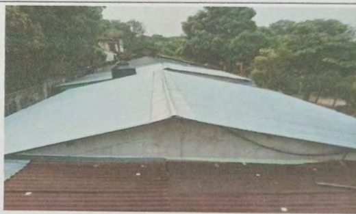
Foto 4: MODULO B Vista exterior de la cubierta en aula ya finalizada.
