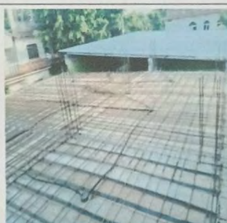
Foto 16: MODULO A Vista de colocación de refuerzo en el armado de losa y colocación de ductería para instalación eléctrica, con las cajas octogonales colocadas en puntos estratégicos para mejor distribución de iluminación. Vista de conformación de mezcla para darle el acabado final.
