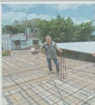
Foto 13: MODULO A Vista de AULA. En compañía de presidenta de OPF y de directora del plantel escolar, así mismo vista de armado de losa con el refuerzo ya colocado.
