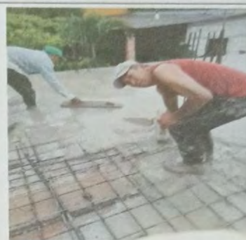
Foto 14: MODULO A Vista de AULA se está trabajando en el armado de la losa, se revisa el desarrollo de bastones, en general la conformación de la canasta estructural por paneles de apoyo. Está en proceso de fundición dando el espaciamiento de el concreto sobre la armadura.
